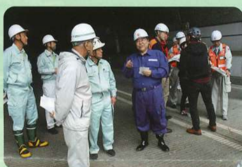
▲権兵衛2号橋崩落現場
